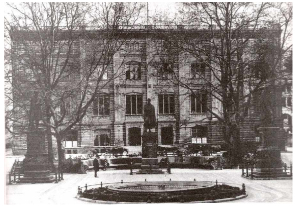
Bauakademie und Schinkelplatz (Foto 1888)
