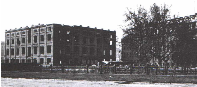
Ausgebrannte Bauakademie und beschädigtes Bankgebäude am Schinkelplatz in den 50er Jahren, Foto Dr. Helmut Maier
