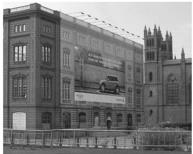
Musterfassade (links in der Abbildung) und Nordseite der Schauffassade, rechts: Friedrichswerdersche Kirche Foto: Wolfgang Schoele (2009)
