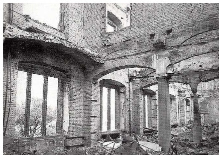
C5: Bauakademie- Ruine 1948 1. OG (Goerd Peschken)
