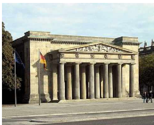
B5: Neue Wache, Unter den Linden Bauzeit: 1816 - 1818
