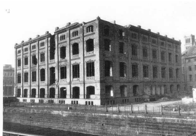
E5: Ausgebombte Bauakademie (Nord-Ost-Fassaden, Foto um 1959): Dr. Helmut Maier
