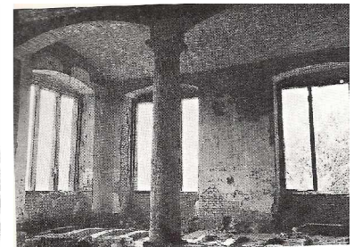
E7: teilrekonstruierte Bauakademie, 1. OG – 1960 – Blick auf die Schleusenbrücke (Aufruf zur Rettung der Bauakademie – Goerd Peschken –
